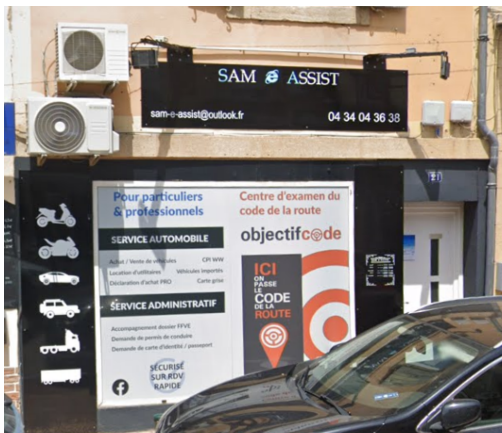
Façade commerciale dépassant a priori le seuil autorisé de surface cumulée d'enseigne sur façade, Remoulins
