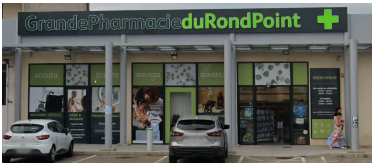
Façade commerciale dépassant a priori le seuil autorisé de surface cumulée d'enseigne sur façade, Remoulins
