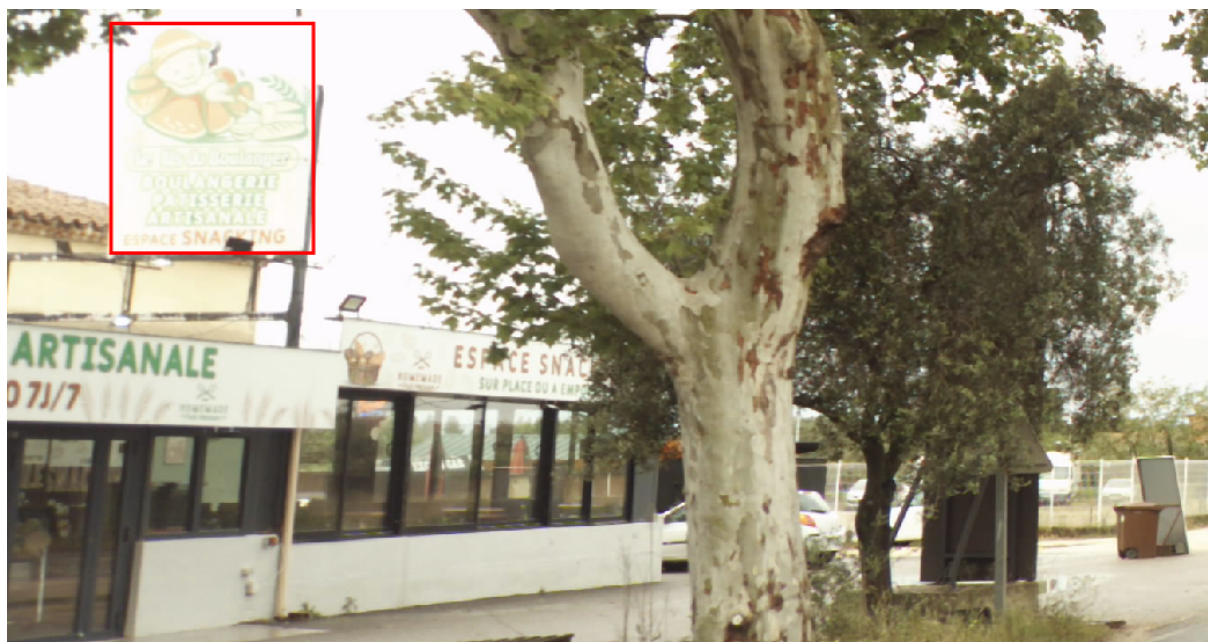
Enseigne sur toiture non réalisée en lettres découpées, Remouins
