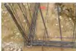
Nœud de chaînage - Continuité mécanique
