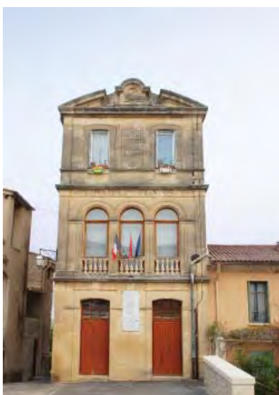
Deux témoignages de finition traditionnelle à Dions et à Remoulins : façade en pierres appareillées (à gauche) et façade en pierre de tout-venant enduite (à droite)
