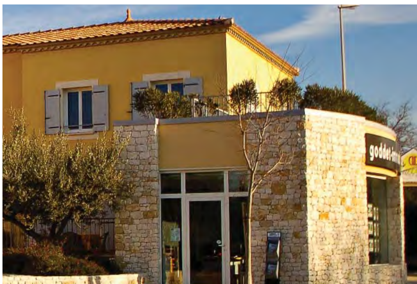
Terrasse aménagée sur rez-de-chaussée commercial à Poulx
