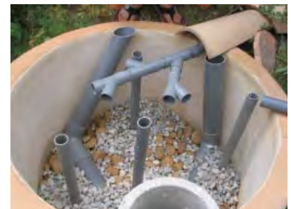
Des drains de fond (Ø : 100 mm) reliés à la surface par des tubes PVC et des tubes verticaux d'aération percés (Ø : 50 mm), sont insérés au moment où l'on place la couche de galets de fond.
