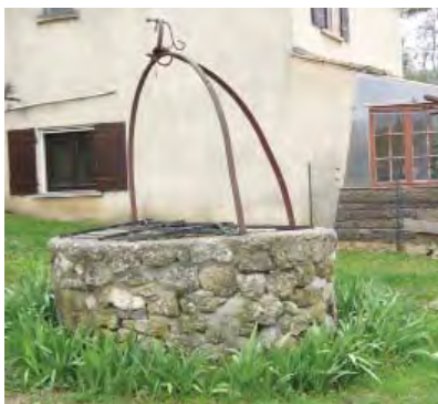
Puits à Dions
