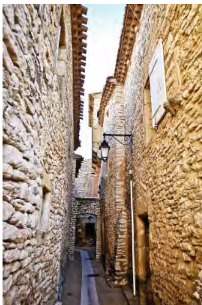
Lorsqu'elles sont apparentes, les parois en pierre de tout-venant présentent des joints en creux, comme "vides" (ici à Cabrières)
