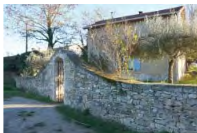
Mur contemporain en pierre sèche à Collias
