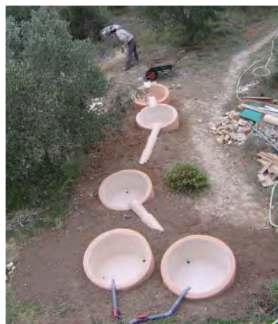
Réalisation de bassins-filtres (Ø:1m)
