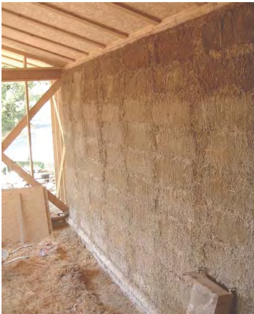
Mur en bottes de paille avant enduit
