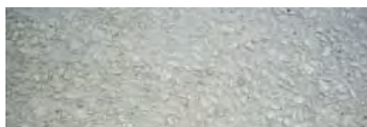
Béton désactivé ou béton de site
