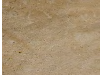
Les enduits choisis dans une couleur proche de la terre environnante sont le garant d'une intégration réussie au site
