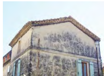
Génoise se prolongeant sur le pignon
