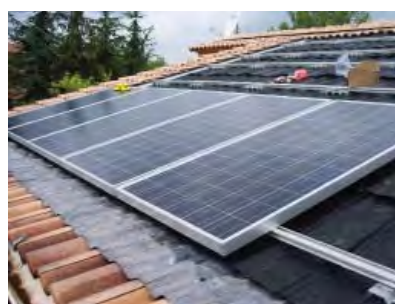
Mise en place de capteurs et de l'étanchéité
