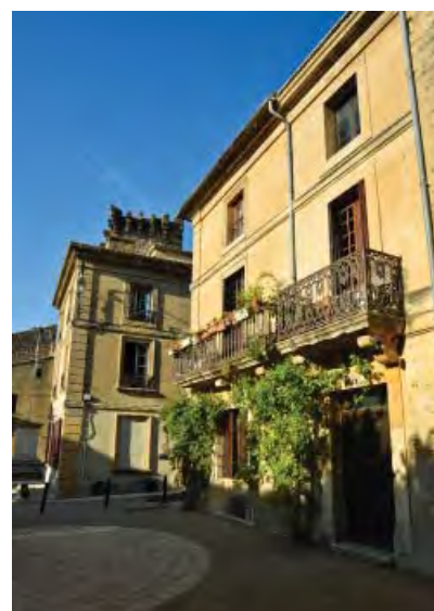
Deux témoignages de finition traditionnelle à Dions et à Remoulins : façade en pierres appareillées (à gauche) et façade en pierre de tout-venant enduite (à droite)
