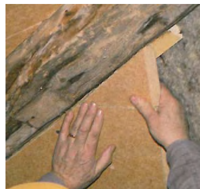
Isolation avec panneaux en fibre de bois
