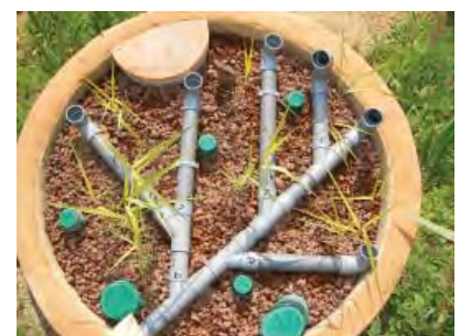
Une araignée de distribution, raccordée à l'arrivée de l'effluent, est posée en surface.
