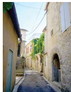
Ruelle à requalifier
