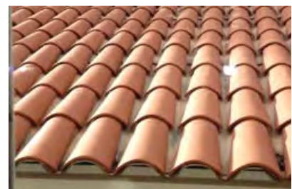
Tuile ronde dite "canal" sur plaque sous-tuile teintée dans la masse, conseillée
