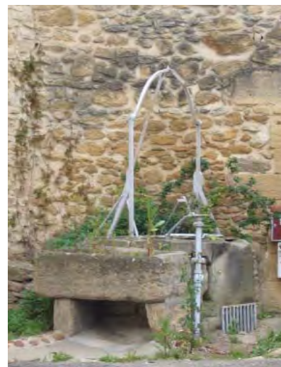
Puits à Sernhac
