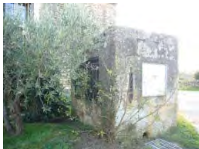
Puits à Vers-Pont du Gard
