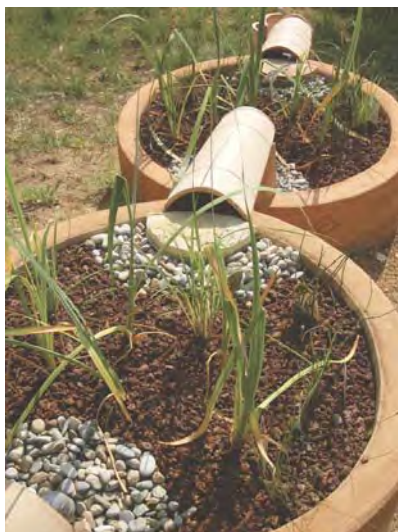
Les bassins-filtre une fois aménagés et plantés.
