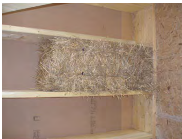
Remplissage d'une ossature bois par des bottes de paille
