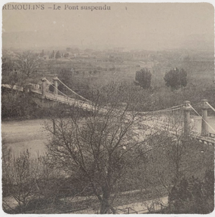
REMOULINS — Le Pont suspendu
