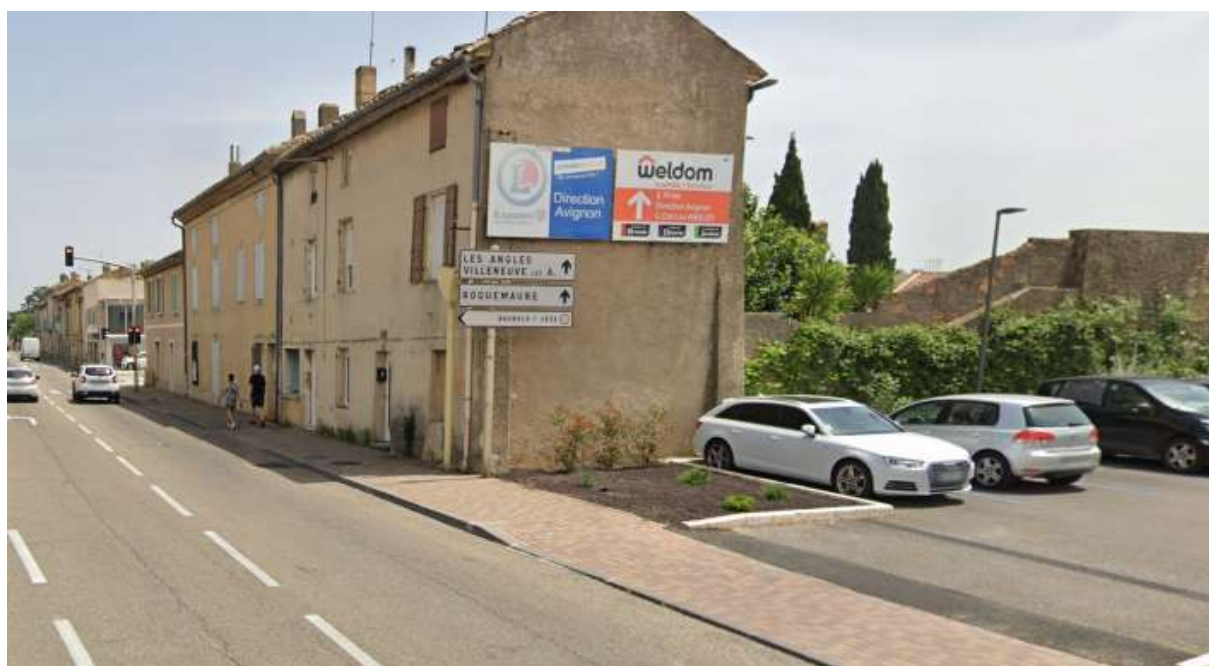
Publicités et préenseignes sur mur de 4 m 2 , Remouls
