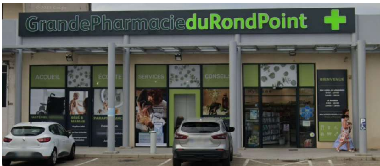
Façade commerciale dépassant a priori le seuil autorisé de surface cumulée d'enseigne sur façade, Remoulins
