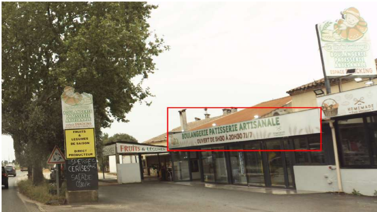
Enseigne parallèle dépassant les limites du mur et de l'égout du toit, Remoullins
