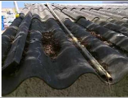
Photo n° PhA001 Localisation : Extérieur - Local Ouvrage : Substrats et revêtements Partie d'ouvrage : Parties accessibles Description : Plafond - panneaux fibro-ciment Localisation sur croquis : 001
