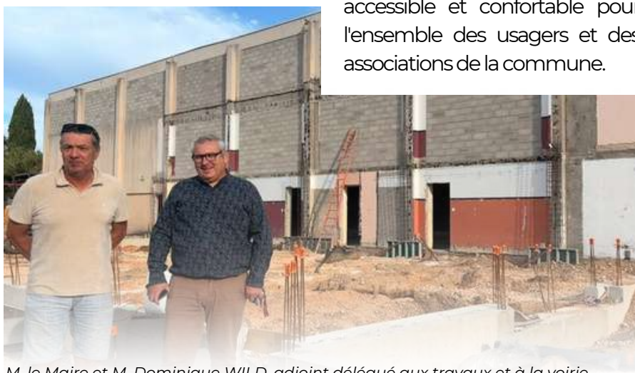
M. le Maire et M. Dominique WILD, adjoint délégué aux travaux et à la voirie, lors d'une visite de chantier
